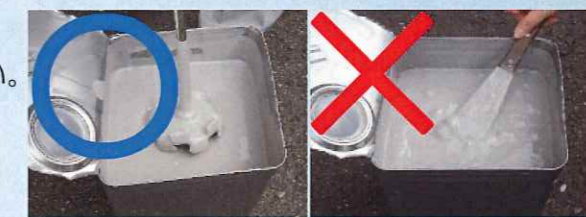
開封時：表面が乾燥 ①ヘラで容器と塗料を切り分ける。 ②固形分に切り込みを入れる。 ③機械で攪拌する。
