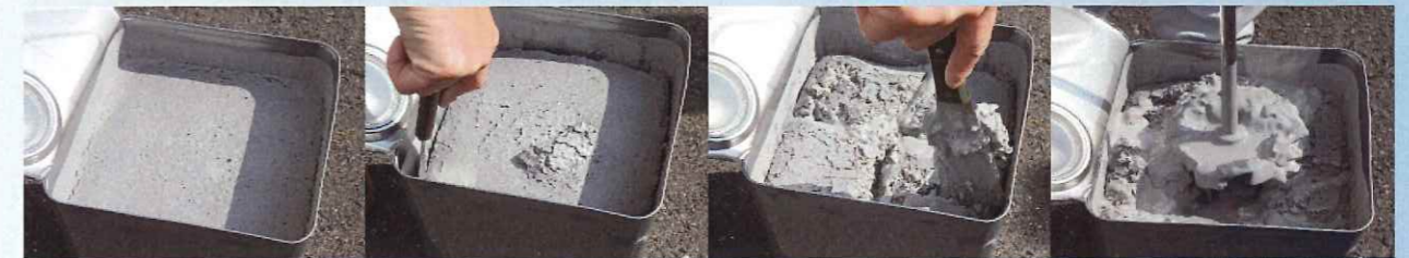
開封時：表面が乾燥 ①ヘラで容器と塗料を切り分ける。 ②固形分に切り込みを入れる。 ③機械で攪拌する。
